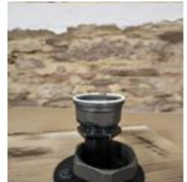
Clip auf Guss -Flansch legen
