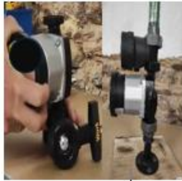
Montage vor /nach Pumpe= identisch
