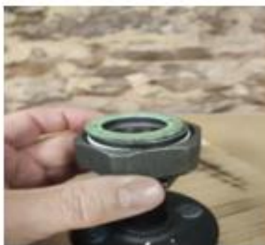
Dichtung einlegen
